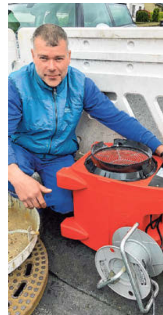
Anstrengend: Johannes Schewalje arbeitet im Kanal. Das Gebläse bringt ihm Frischluft.
