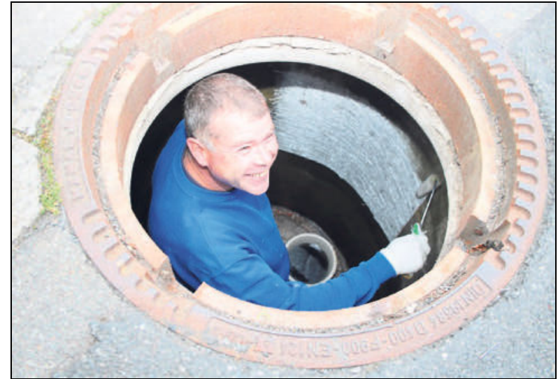
Johannes Schewalje befestigt die Glasfasermatte mit einem Spezialharz an der Innenwand des Kanalschachtes. Fotos: Ruth Matthes
