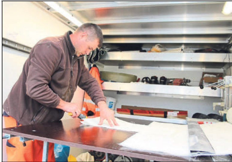
Egor Reich schneidet im Wagen die Glasfasermatten zu, die später Teil der neuen Innenhaut des Kanalschachtes sind.
